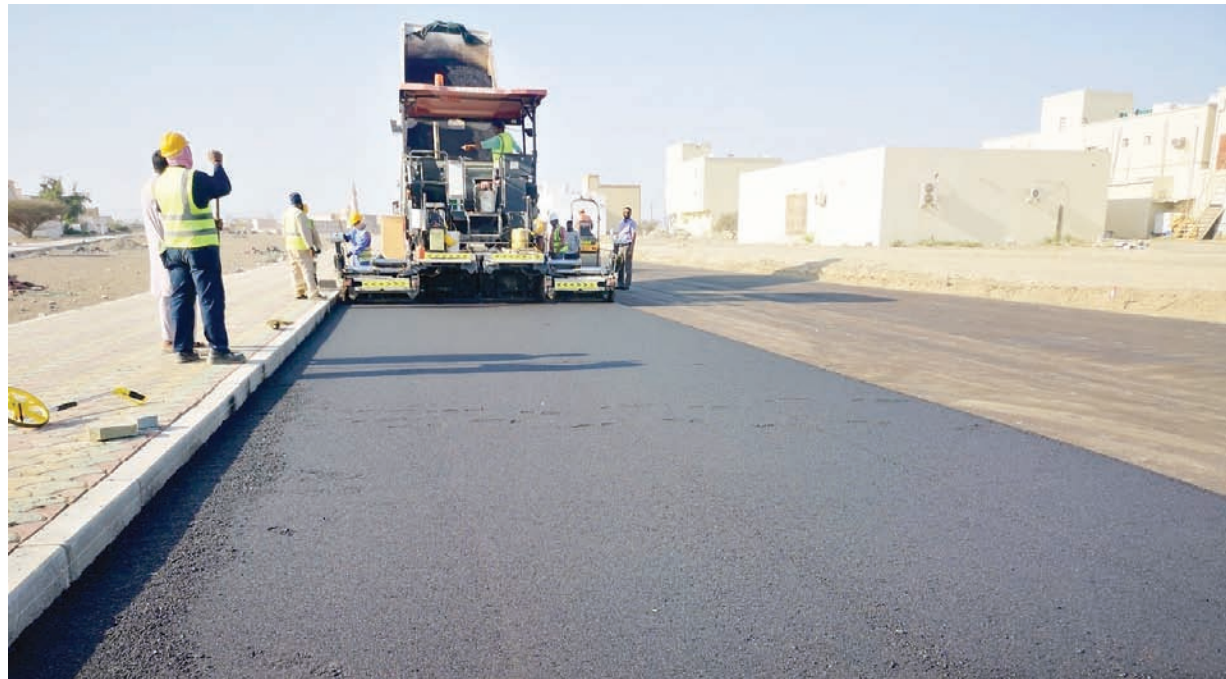
■ من أعمال بلدية شمال الباطنة في رصف الطرق
