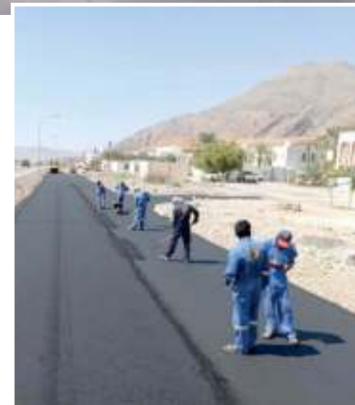
أثناء عملية رصف وصيانة أحد الطرق الداخلية
