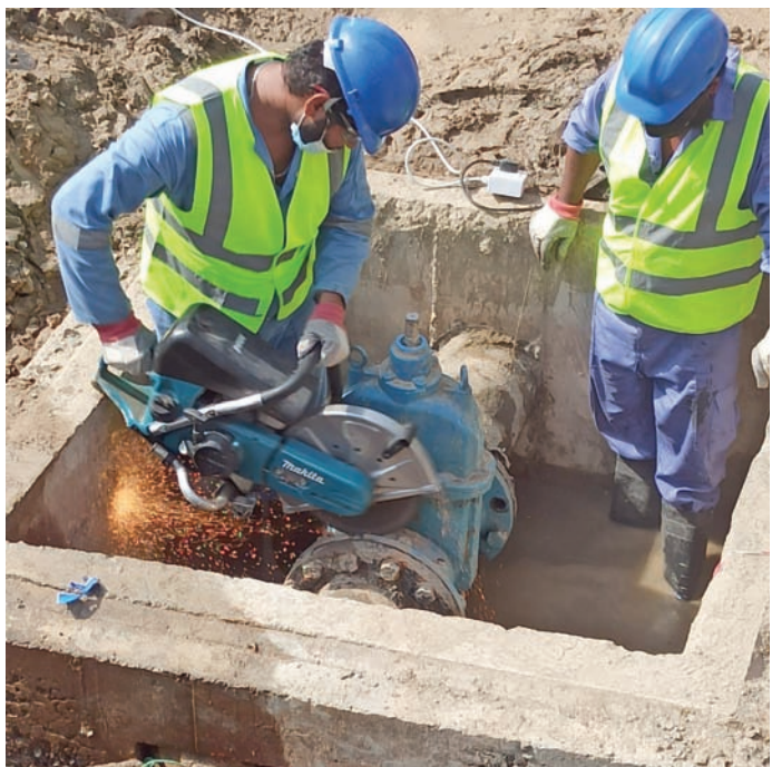
أعمال التحسينات ستشمل تغيير بعض المحابس في محطات ضخ المياه الرئيسية ببركاء والخوض وسمائل
