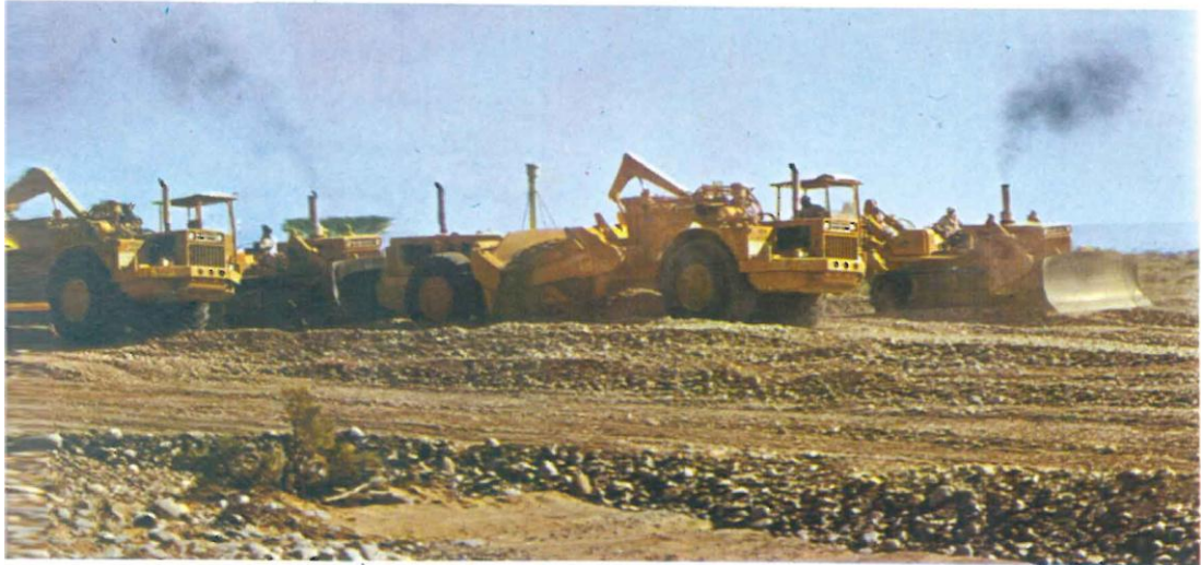
انشاء الطرق الحديثة لمواكبة نهضة عمان الحديثة
