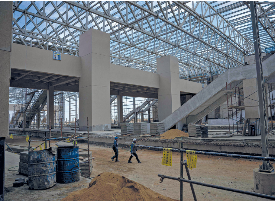
■ عمال مصريون ينفذون أعمال بناء خط السكة الحديدية الكهربائية السريع «الخط الأخضر» في العاصمة الإدارية الجديدة شرق القاهرة وقد بدأ العمال بمدّ القضبان في الصحراء شرق القاهرة لأول قطار فائق السرعة في مصر، والذي سيربط البحر الأحمر بالبحر الأبيض المتوسط.
