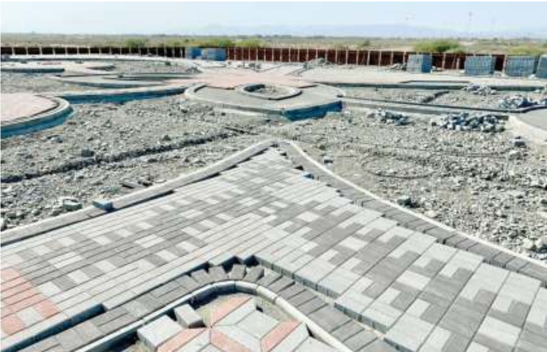
تواصل الأعمال الإنشائية بمشروع الواجهة البحرية بشناص
