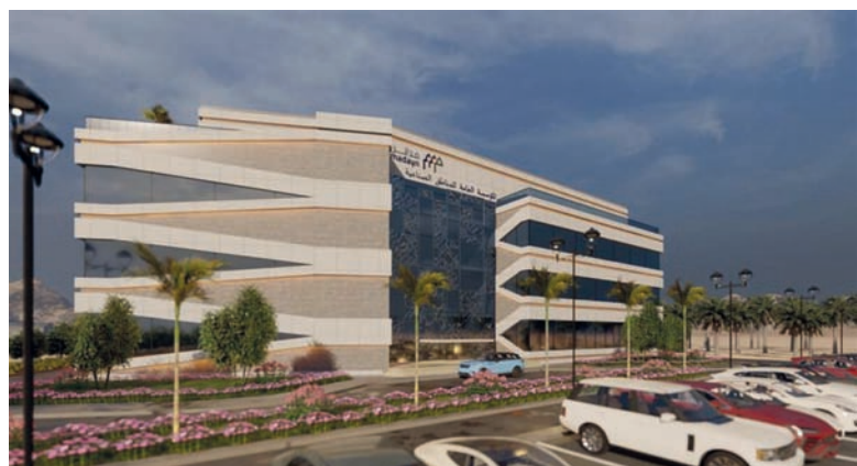
■ مبني الخدمات والتسهيلات في المنطقة الحرة بالمزيونة
