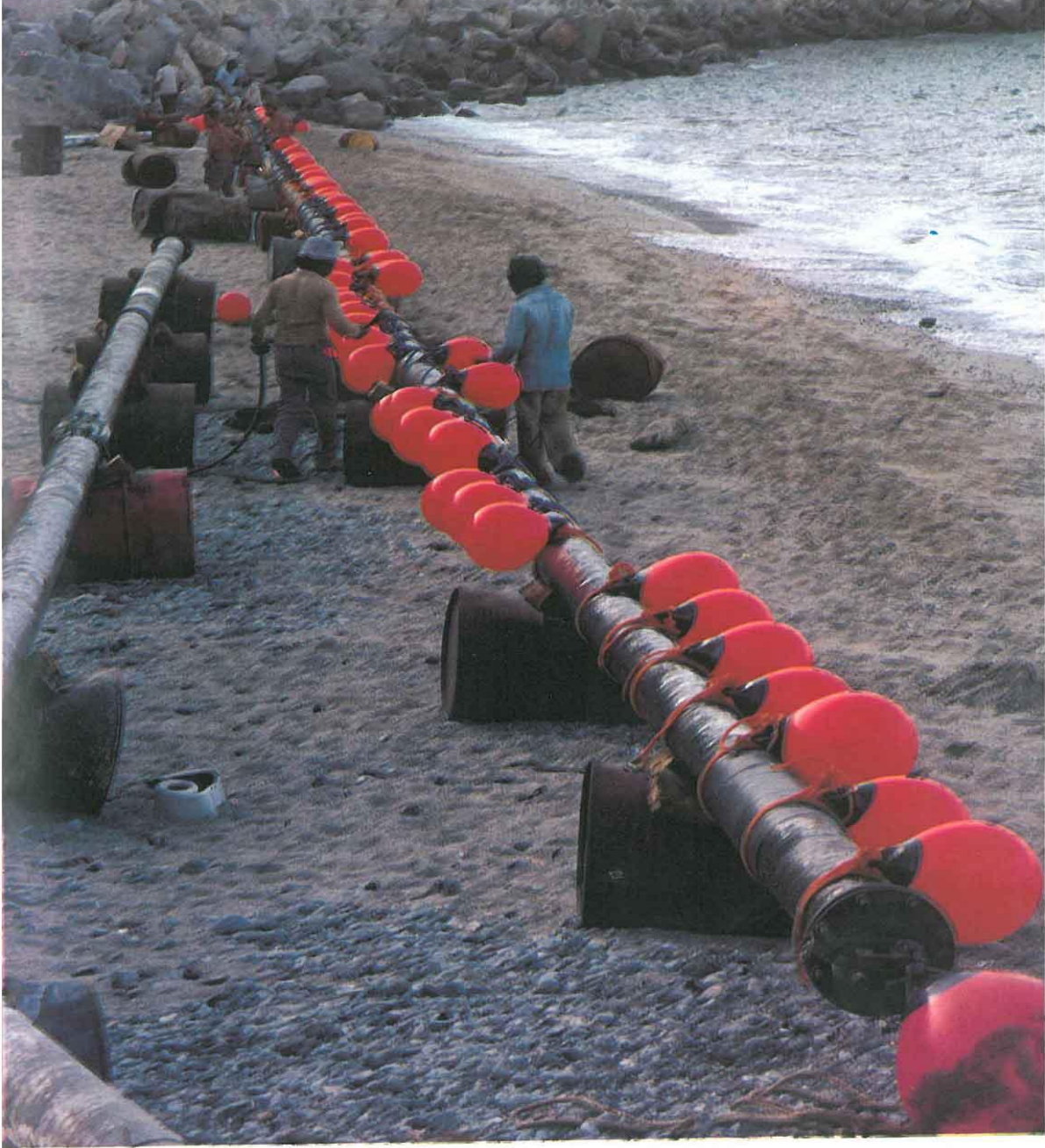
خط أنابيب النفط الذي يجري الإعداد لمدة عبر مياه البحر عند شبه جزيرة مسندم . ويوفر الخط التسهيلات اللازمة لتفريغ النفط اللازم لمنطقة خصب .
