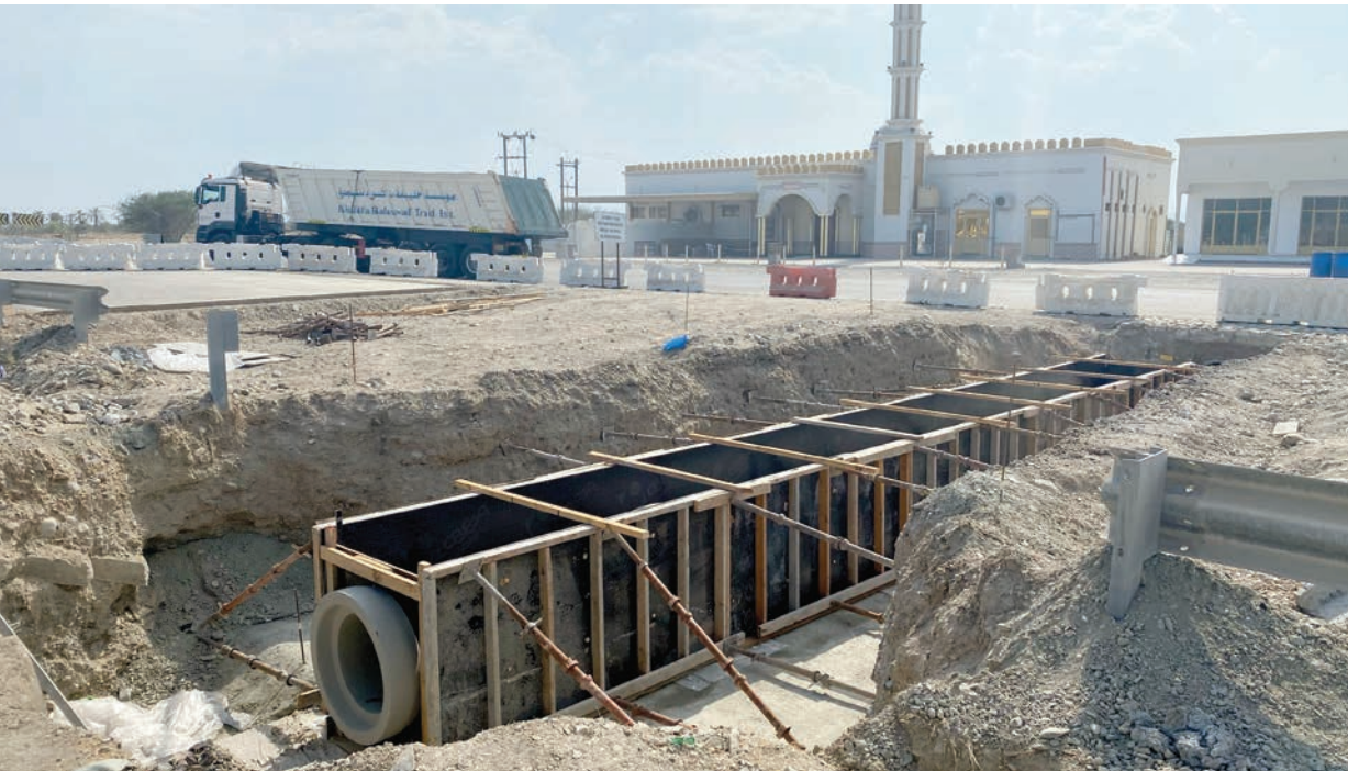
■ أثناء عملية إصلاح الحفرة بالشارع
