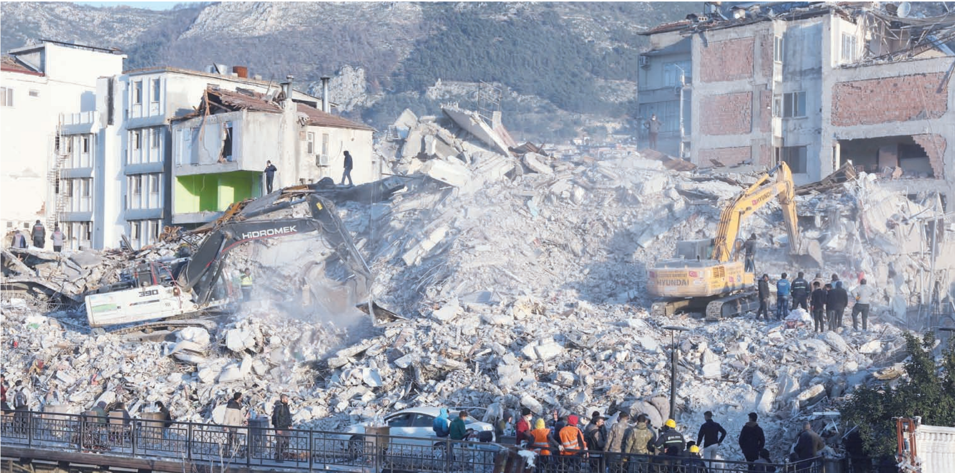
■ فرق البحث والإنقاذ تعمل على المباني المنهارة في أعقاب الزلزال الذي وقع في هاتاي. «رويترز»
