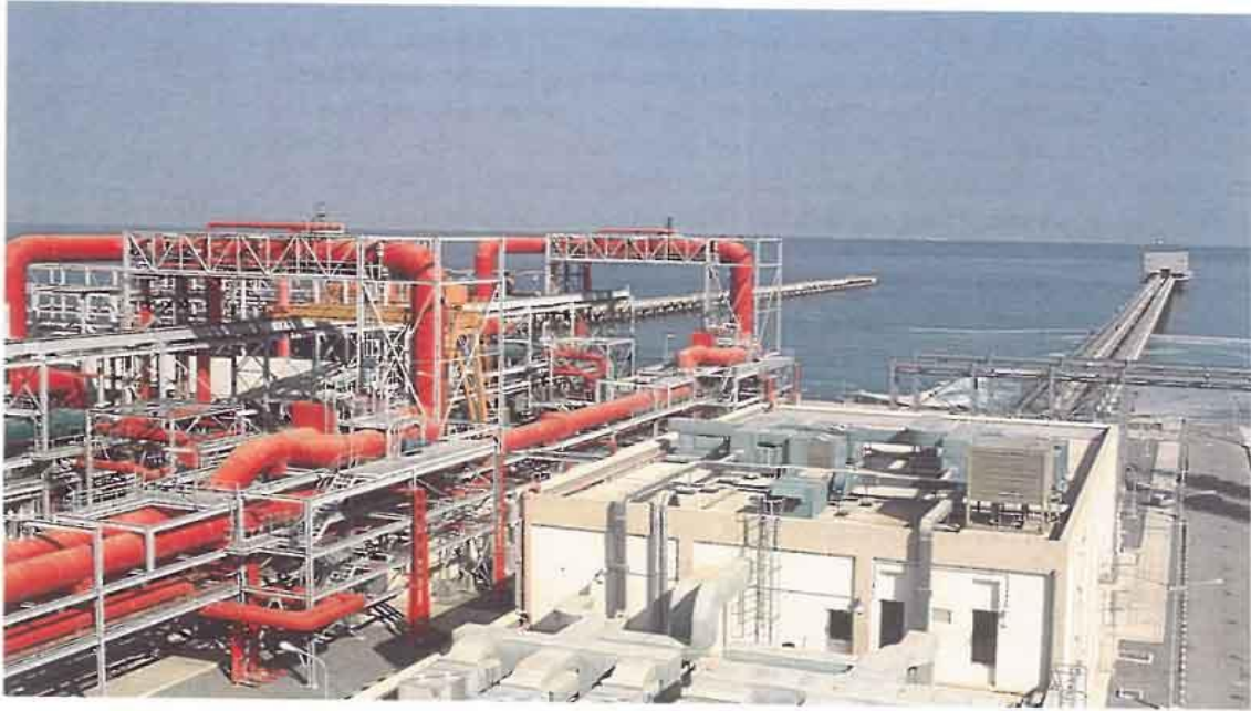
La planta de desalinización de Al Ghubrah cubre la creciente demanda nacional de agua. (Foto: Christian Vioujard)
