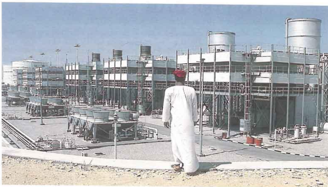
La planta eléctrica de Rusayl proporciona electricidad para el desarrollo industrial de la nación. (Foto: Christian Vioujard)
