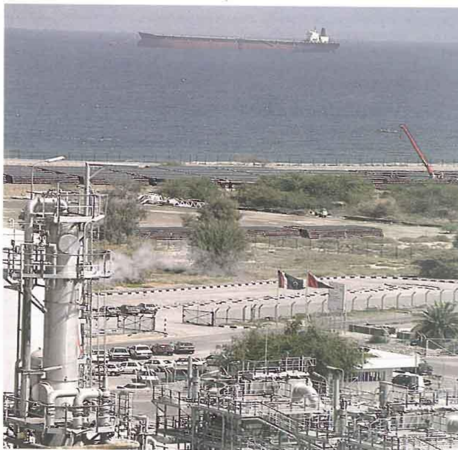
La refinería de PDO en Mina Al Fahal. Al fondo, un tanque cargando. (Foto: Christian Vioujard)
