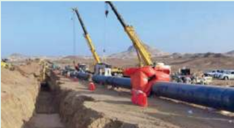
■ تواصل تمديد وتركيب أنابيب المياه ومضخاتها
