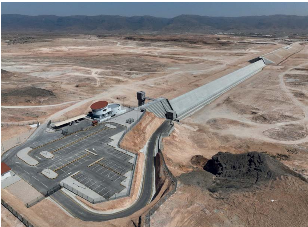
■ حجز مياه الفيضانات القادمة عبر الوادي وحماية وتأمين ميناء صلالة
