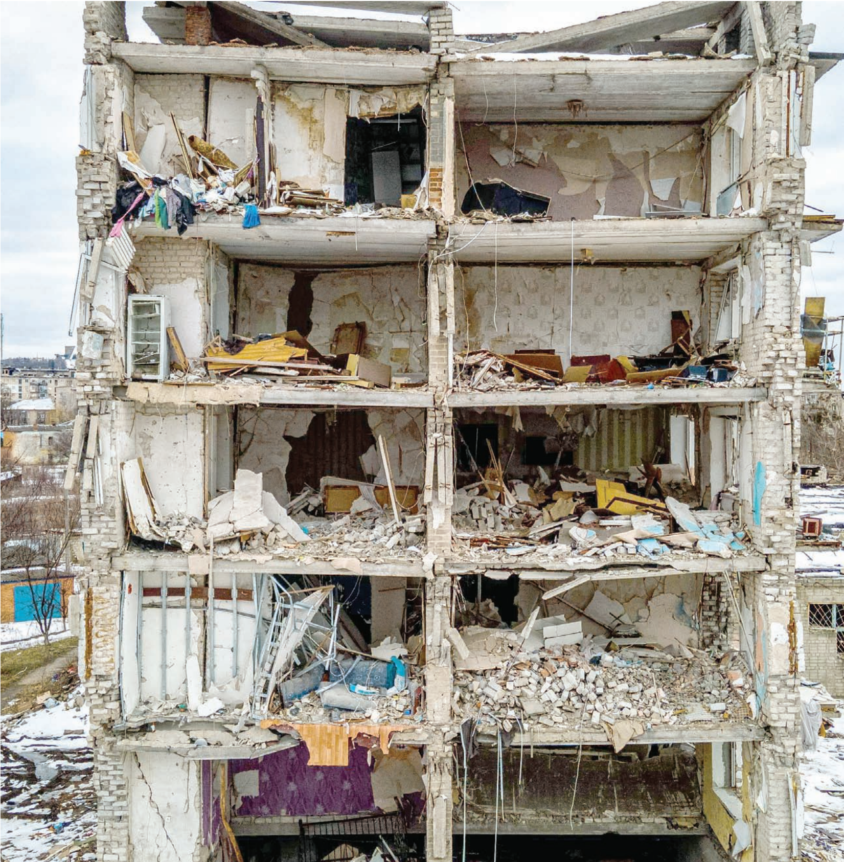
■ منظر جوي يظهر مبنى سكنيا تضرر جراء القصف في إيزيوم بمنطقة خاركيف مع استمرار العمليات القتالية بين الجانبين الروسي والأوكراني. «أ.ف.ب.»
