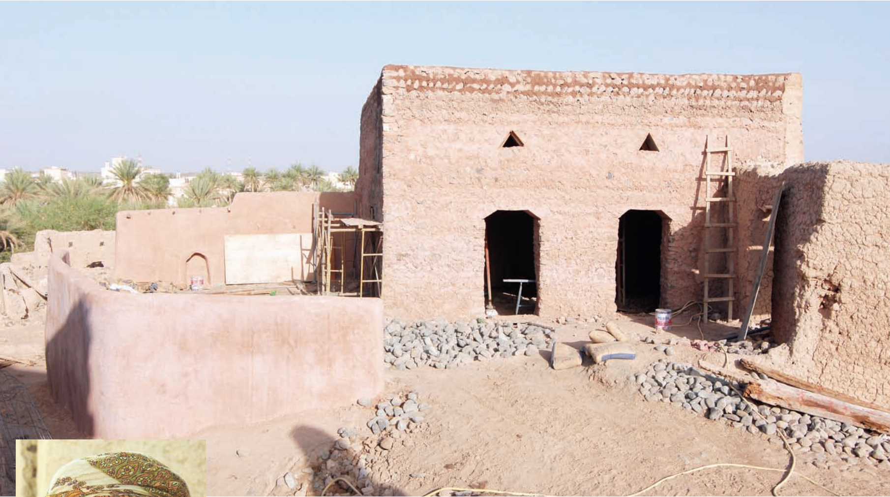
■ جانب من أعمال الترميم
