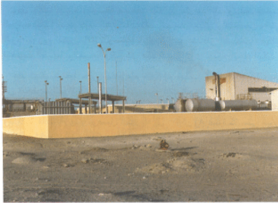
احدى محطات توليد الكهرباء في الولايات
