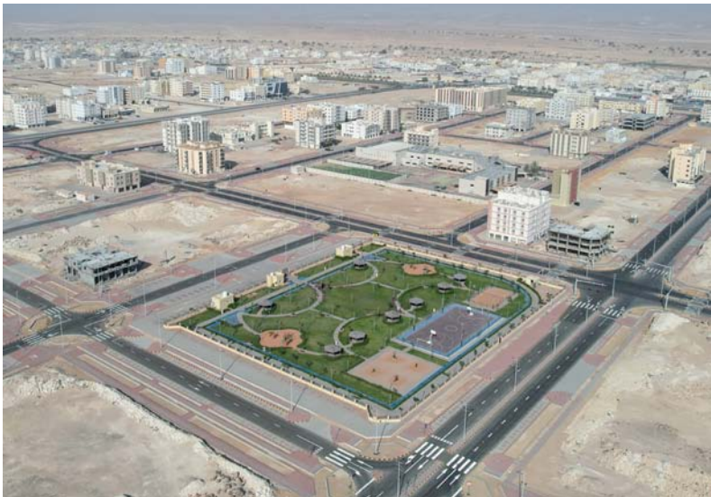
■ مشروع إنشاء شبكة الطرق في المخططات سيسهم في رفع كفاءة منظومة النقل
