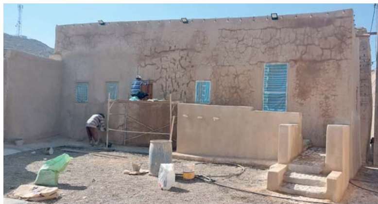
■ مشاهد من إعادة ترميم وإحياء حارات ودكاكين بلدة بلادسيت
