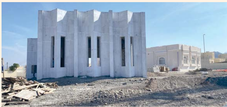
أعمال البناء متواصلة بجهود أصحاب الخير
