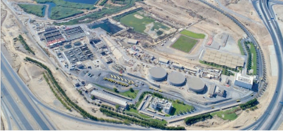
المشروع ربط عددا من المباني التجارية والحيوية بشبكة الصرف الصحي ومد خط للمياه المعالجة لمبنى عمان مول بطول ٨٠٠ متر.
