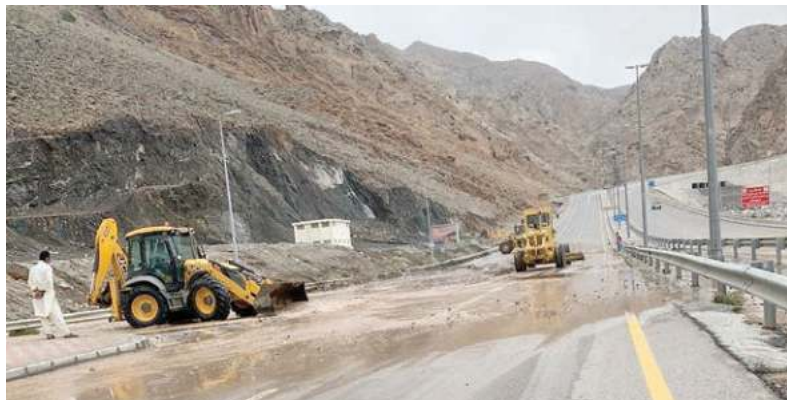
■ أعمال فتح الطرق وإزالة مخلفات السيول
