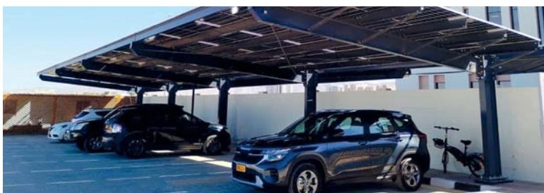
■ المشروع يسهم في خفض التكاليف التشغيلية للكهرباء
