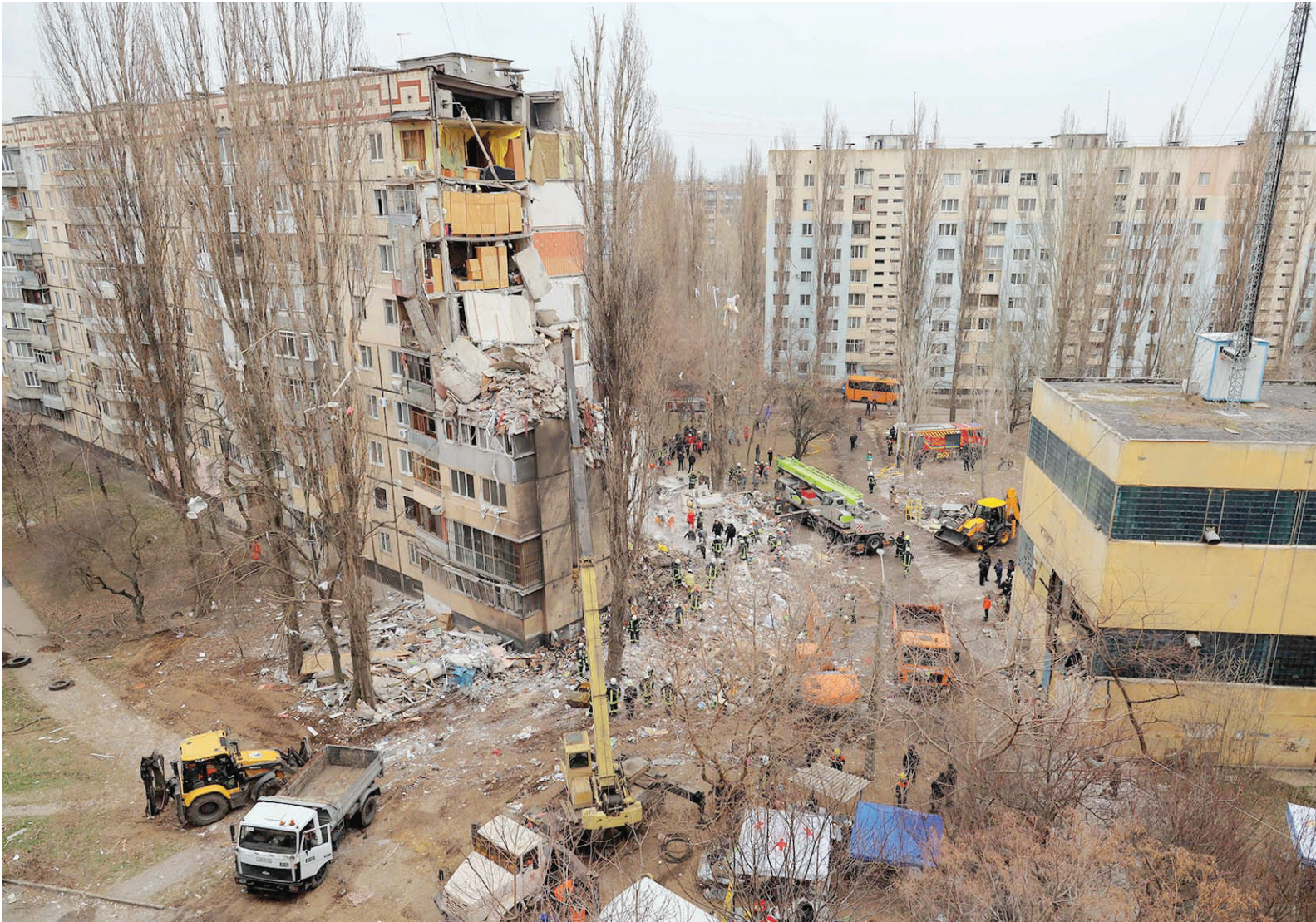
■ رجال الإنقاذ يعملون في موقع مبنى سكني متعدد الطوابق تعرض لأضرار بالغة، إثر هجوم بطائرة روسية بدون طيار، في منطقة أوديسا «أ.ف.ب»
