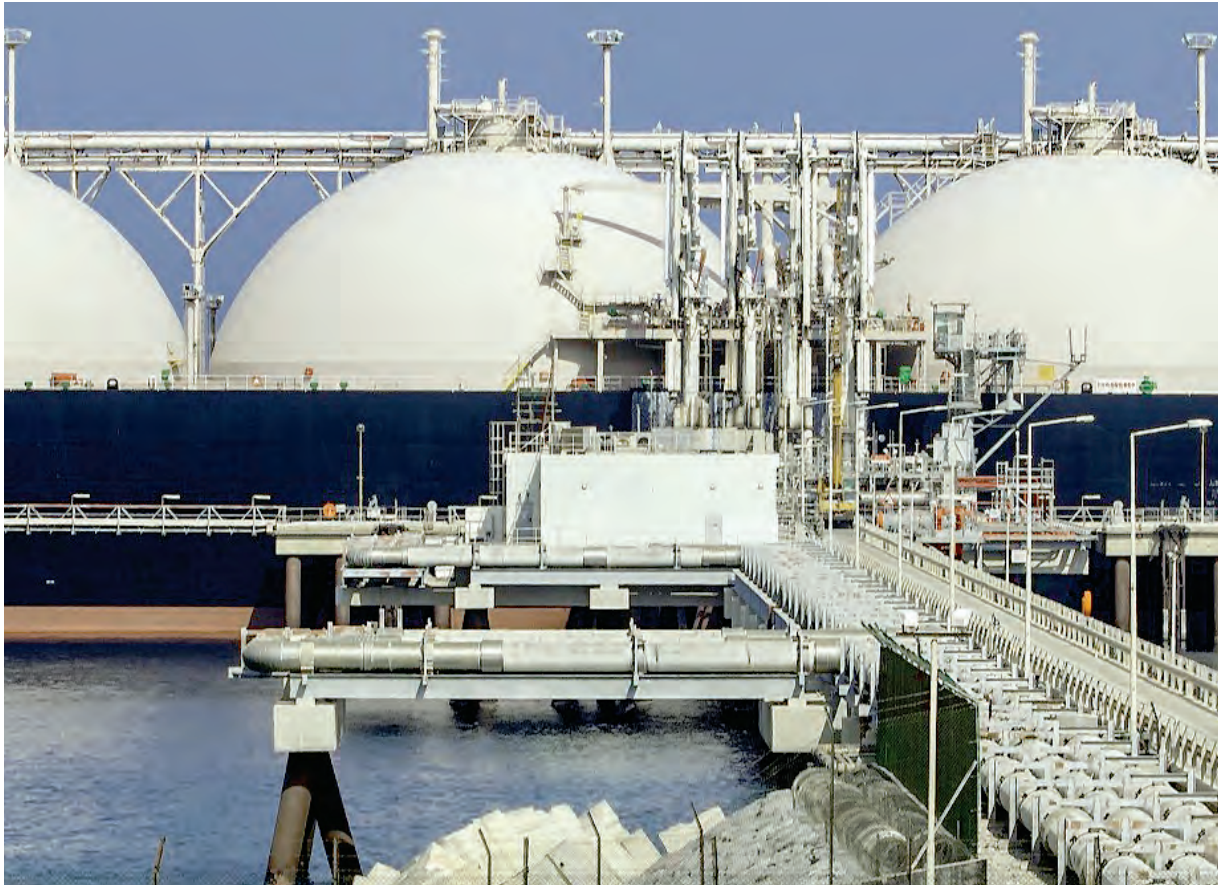
Oman LNG’s complex at Qalhat.
