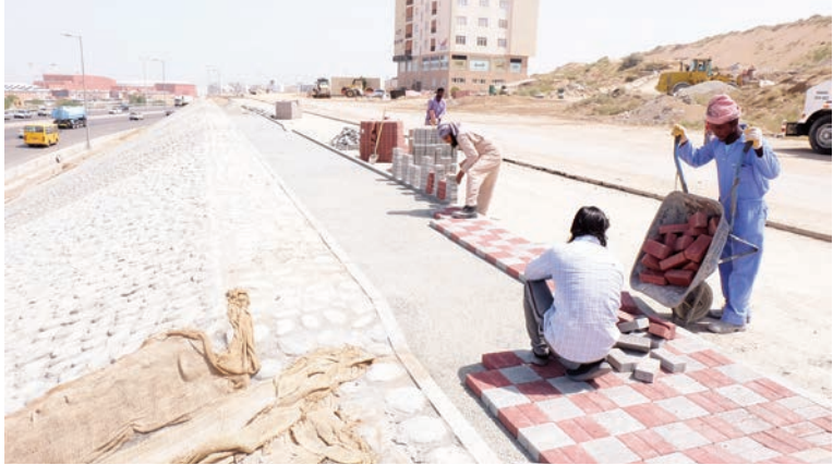
■ من أعمال رصف الطرق الداخلية ببوشر
