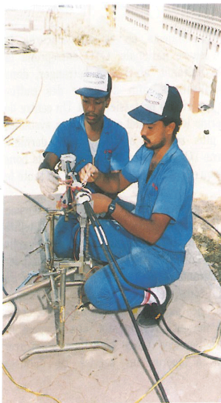
► Des techniciens omanais effectuent du travail d'entretien sur le terrain.
