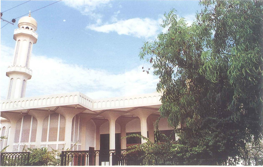
نهضة البناء فُعلي (مآذن الإسلام) بولاية أدم.
