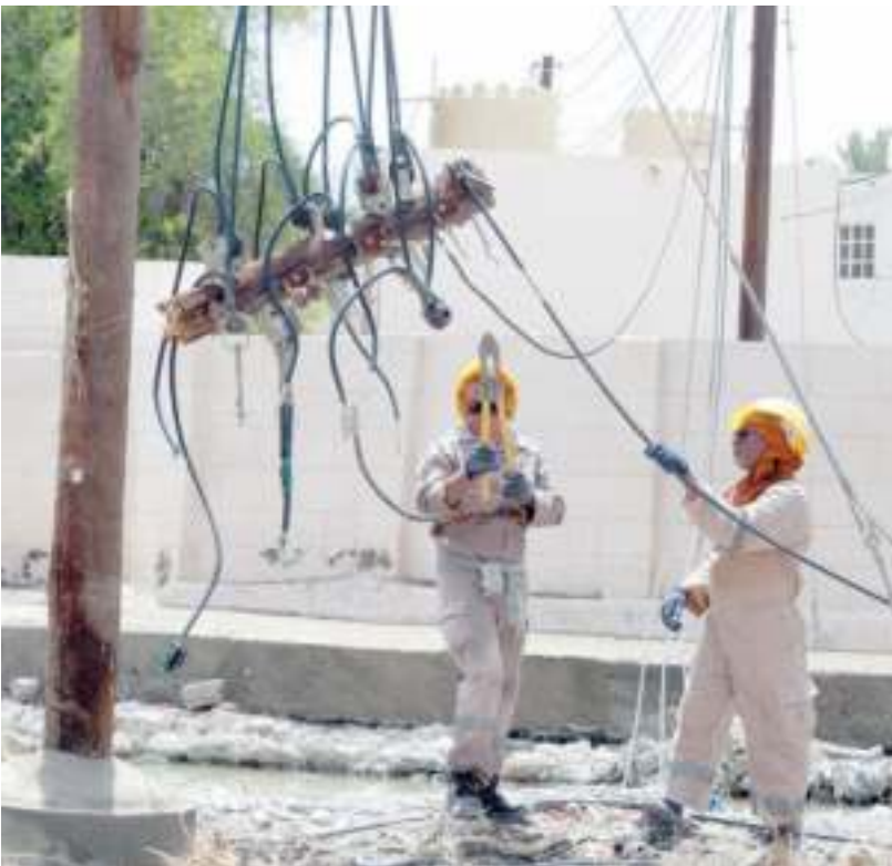
■ أعمال إصلاح التيار الكهربائي
