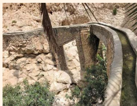
■ استخدام مواد بناء من البيئة العمانية في أعمال التأهيل
