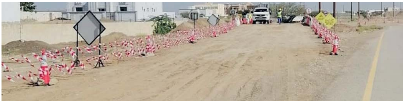
أثناء أعمال صيانة الطريق
