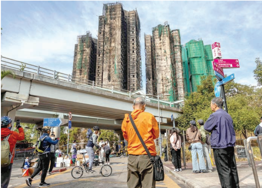
■ آثار الحريق الهائل الذي اجتاح عدة مبانٍ سكنية في مجمع وانغ فوك كورت السكني في منطقة تاي بو بهونغ كونغ «
