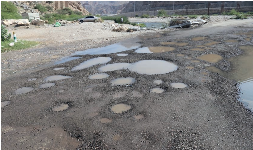
■ الطريق تكثر به الحفر والتشققات وبحاجة إلى إنشاء عبارات صندوقية
