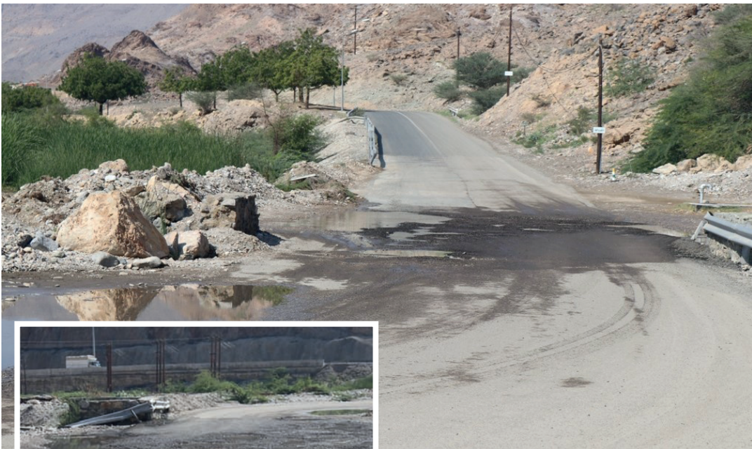
■ الطريق تكثر به الحفر والتشققات وبحاجة إلى إنشاء عبارات صندوقية
