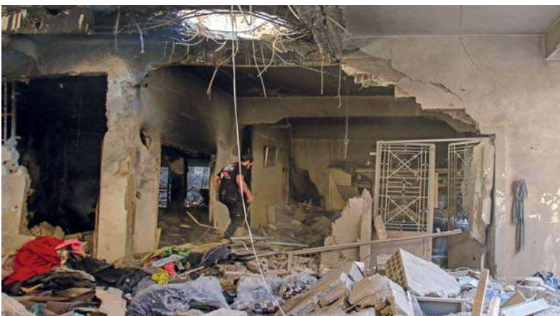
لبناني يتفقد أضراراً لحقت بمنزل أصيب جرّاء غارة جويّة إسرائيلية على مدينة بعلبك شرق لبنان.
