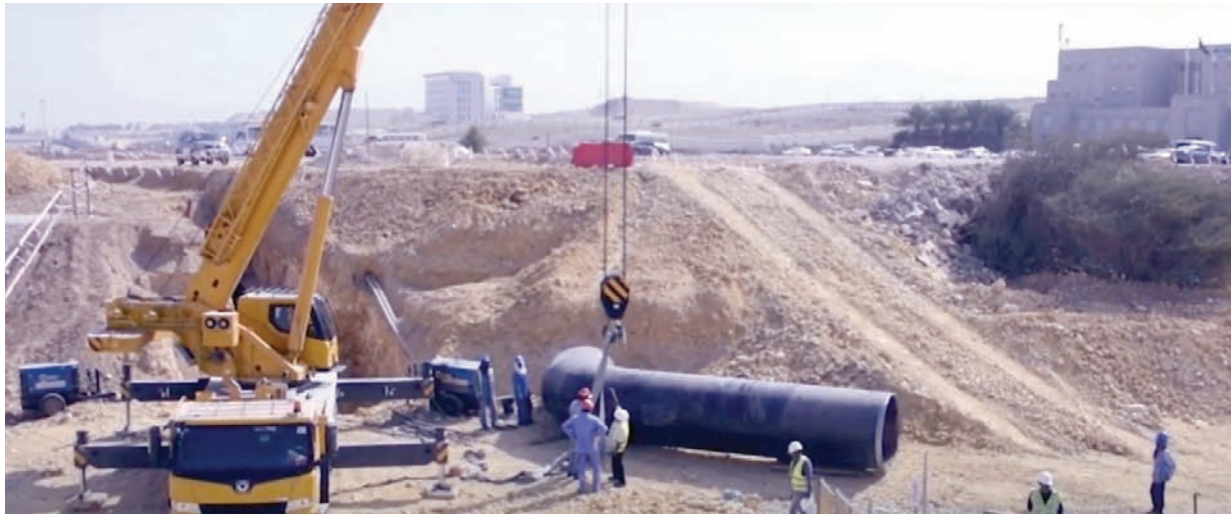
■ من أعمال المشروع الاستراتيجي لنقل المياه بوشر - السيب
