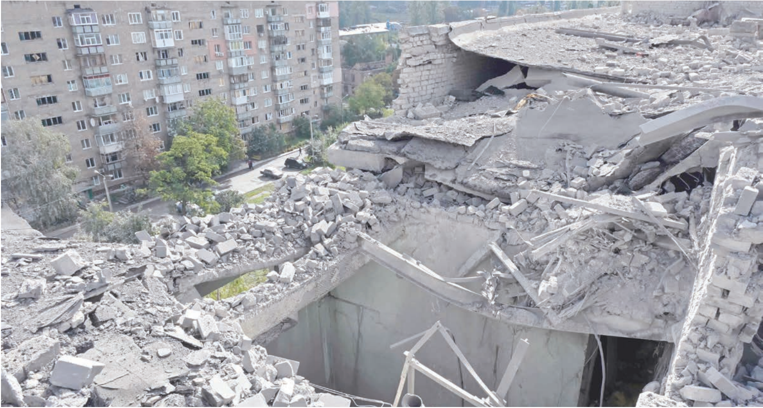
■ سقف مبنى سكني تضرر بعد قصف على خاركييف في الحرب الروسية الأوكرانية.
