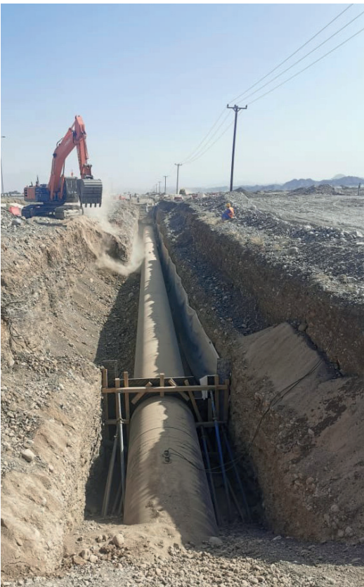
■ المشروع يعزز نظام نقل المياه الحالي بمحافظة الداخلية
