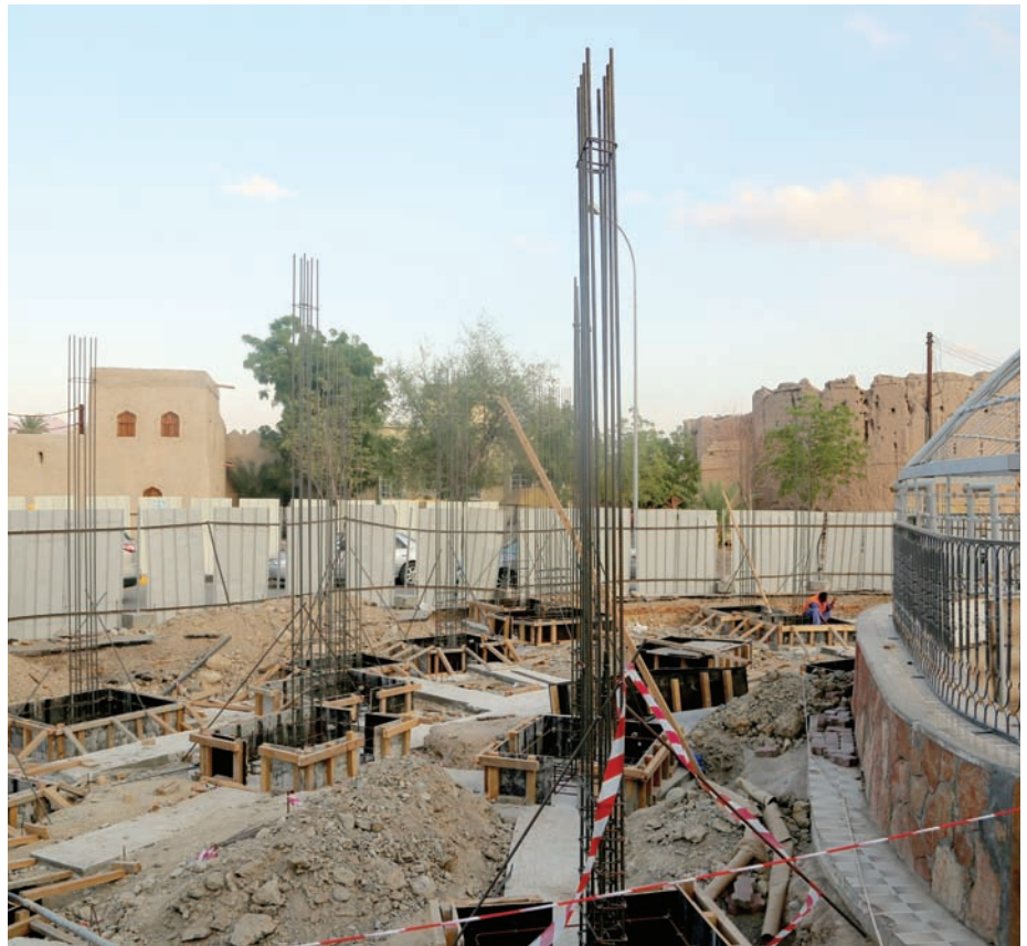
تتضمن أعمال التطوير إنشاء المزيد من المسابح والمظلات ومواقف المركبات بالإضافة إلى مقهى تراثي
