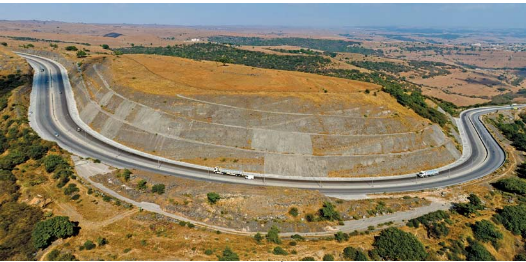
■ تخطيط وتصميم وإنشاء الطرق لمواكبة التقدم الاقتصادي والحضاري
