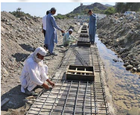
■ تنفيذ أعمال الصيانة لأحد الأفلاج
