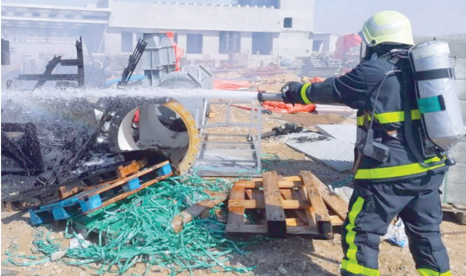
■ إطفاء الحريق بمصنع في مرباط
