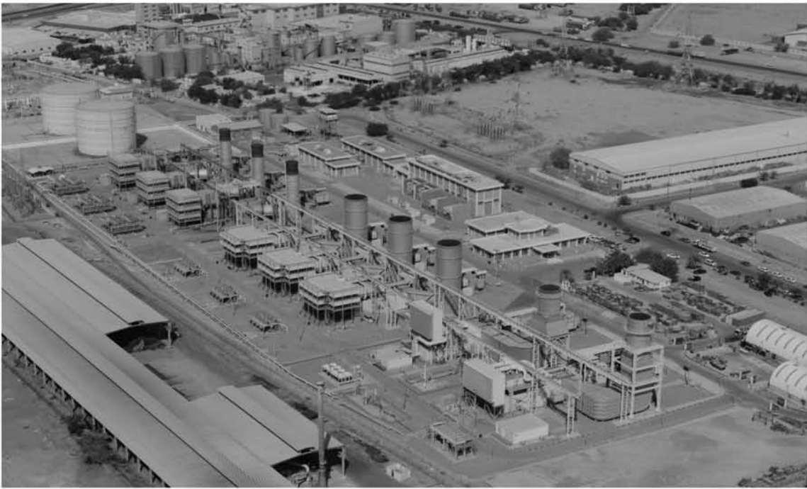
الشكل ١ محطة الرسيل للطاقة
