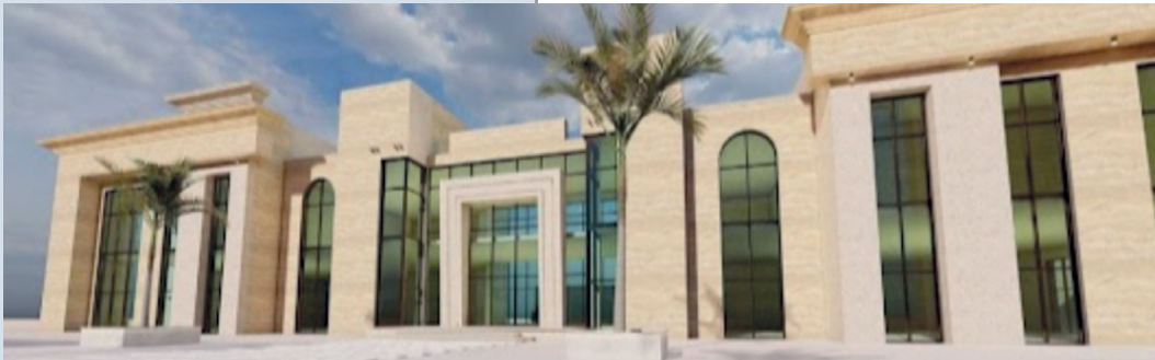
مبنى مركز بهلاء الثقافي قيد الإنشاء
