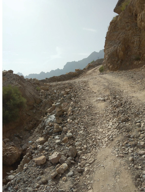
الطريق تتآكل جوانبه وزيادة الحفر به جراء الأمطار
