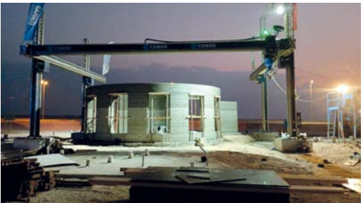
الشروع يسهم في تشجيع وتوطين التقنيات الحديثة في عمليات البناء
