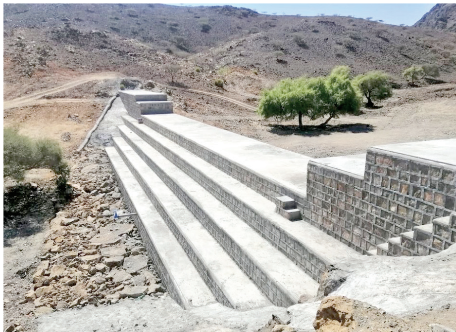
منحدر السد الذي يبلغ طوله الكلي ٣٦ متراً
