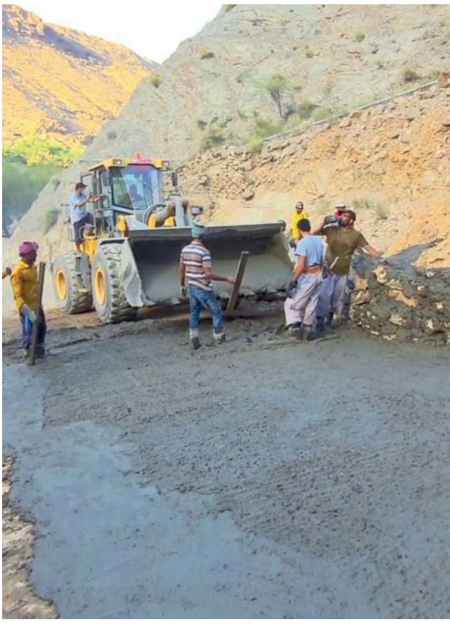
■ أبناء القرية أثناء أعمال رصف وتوسعة الطريق
