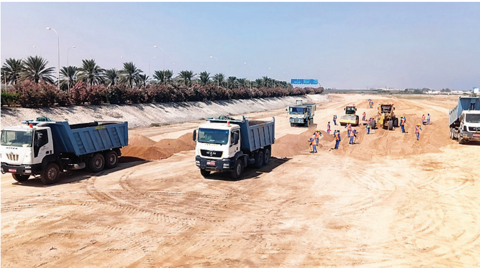
■ تتضمن المرحلة الأولى من المشروع تجهيز وتسوية الأرض وإنشاء شبكة الطرق الداخلية ومرافق الخدمات العامة
