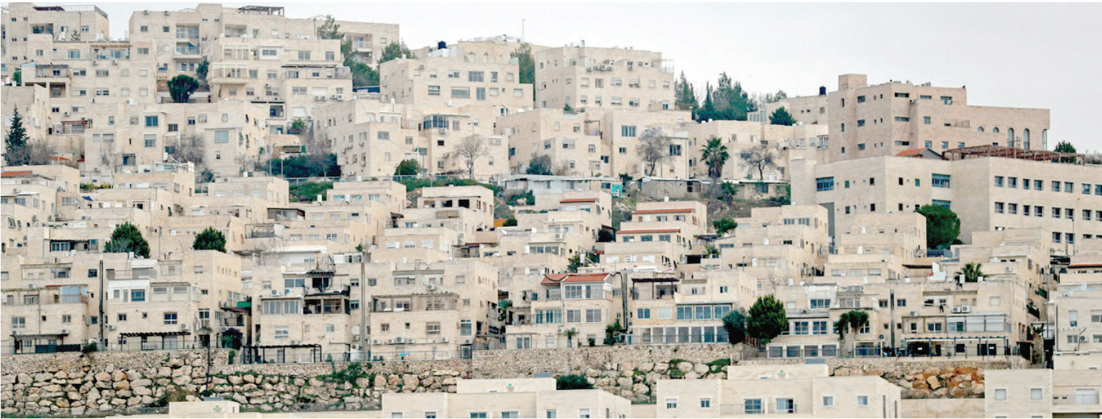
منظر عام يظهر أعمال البناء الجارية في رماث شلومو، المستوطنة اليهودية في القطاع الشرقي الذي ضمته إسرائيل أ ف ب
