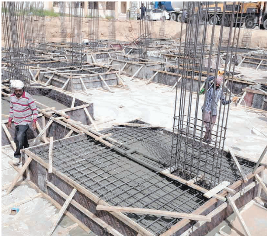
■ مراحل إنشاء مبنى وقف سكني تجاري للجنة الزكاة بجعلان بني بو علي
