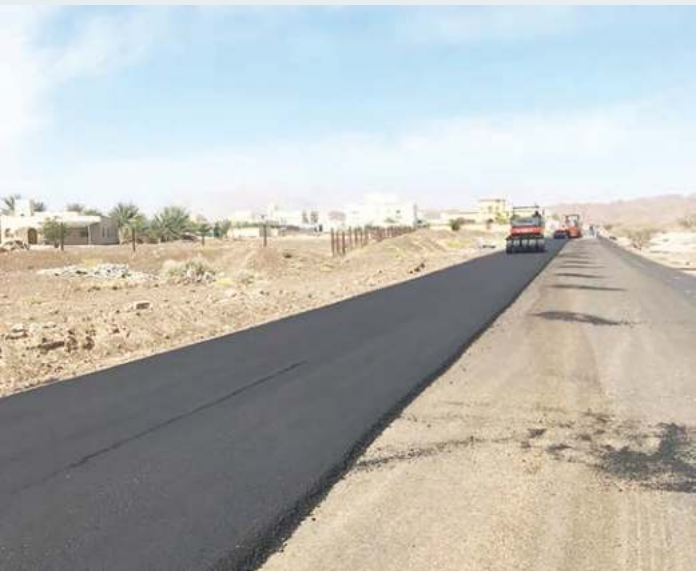
من أعمال الرصف للطرق الداخلية ببها
